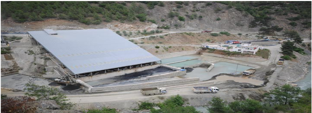
Şekil 8. Tesisin Genel Görünüşü.
