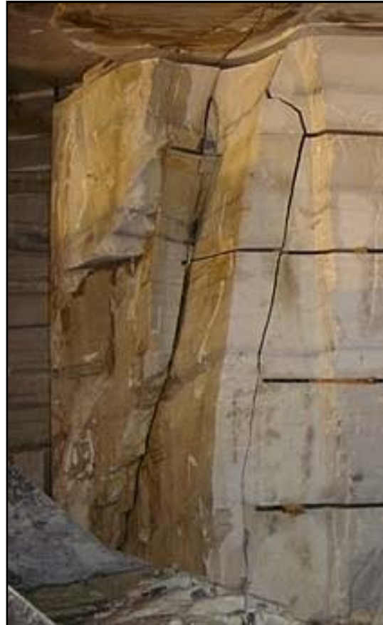
Şekil 11 Formasyondaki süreksizliklerin topuk üzerine etkisi (Anon (m))
